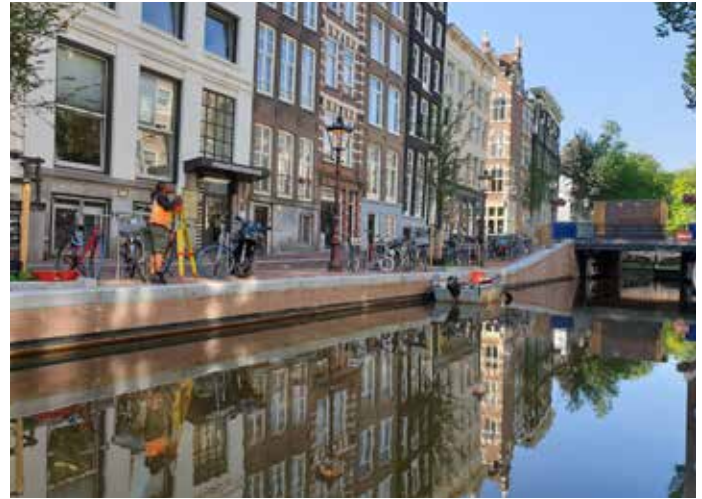
Werkzaamheden bij verbetering van kademuren.
